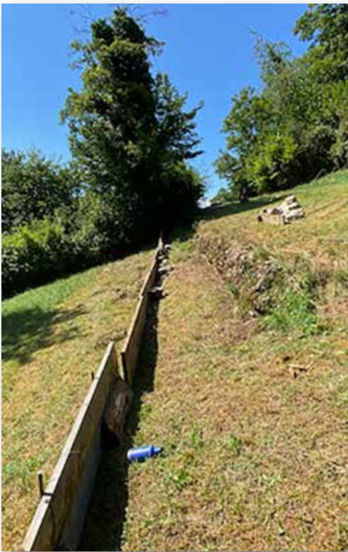
19.-23.08.2024: Die dritte Trockensteinmauer wurde neu aufgebaut.
